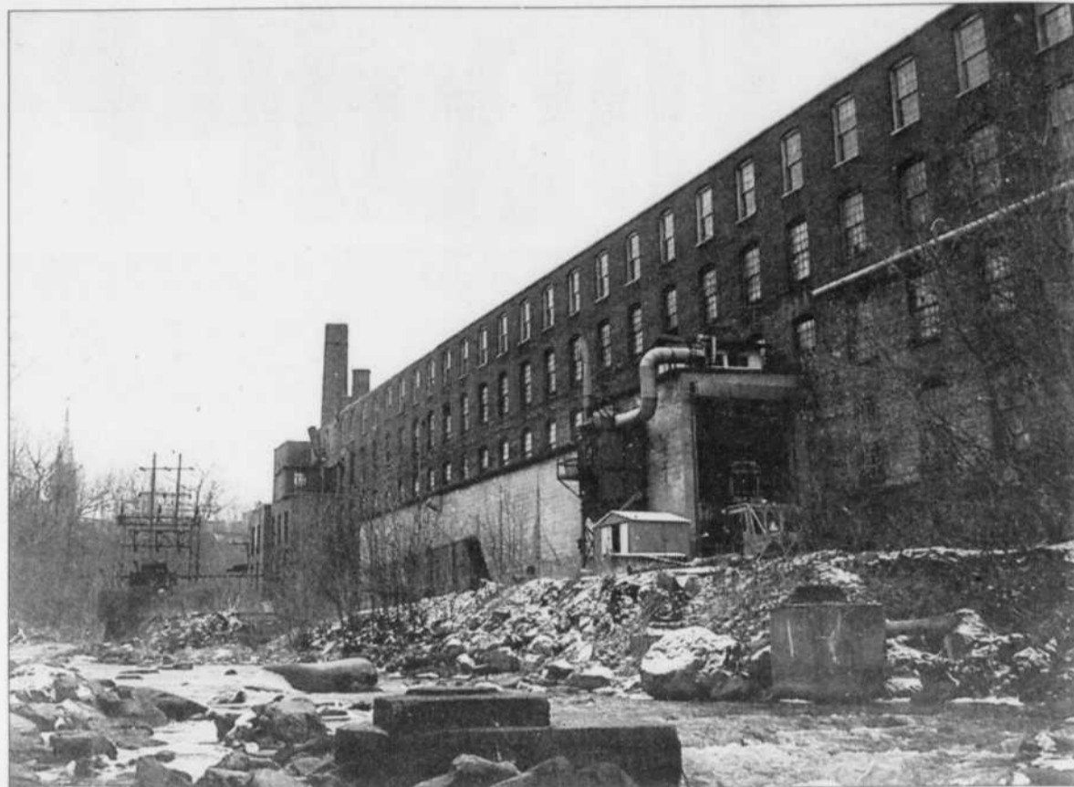
Une étude du sous-sol des terrains de l'ancienne usine Miner révèle des traces d'hydrocarbures et de métaux lourds, dont du plomb, dépassant les normes acceptables.
