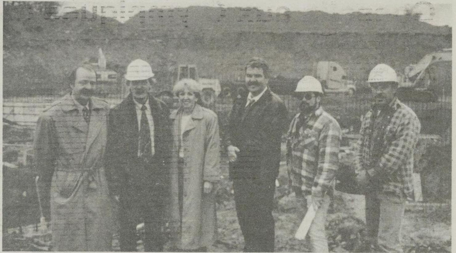
Devant le chantier, réunis pour le lancement des travaux, le député provincial Normand Poulin, le maire Russell Gilbert, la représentante du député Bernier, Paule Bolduc, le directeur des travaux publics Bruno Gilbert, Yvon Grégoire de la firme d'ingénierie GLD et Viateur Turgeon, superintendant des Constructions Beauce-Iles.
