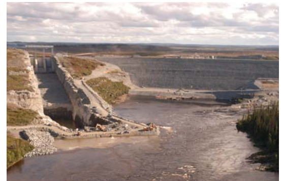
Barrage et évacuateur de l'Eastmain-1
