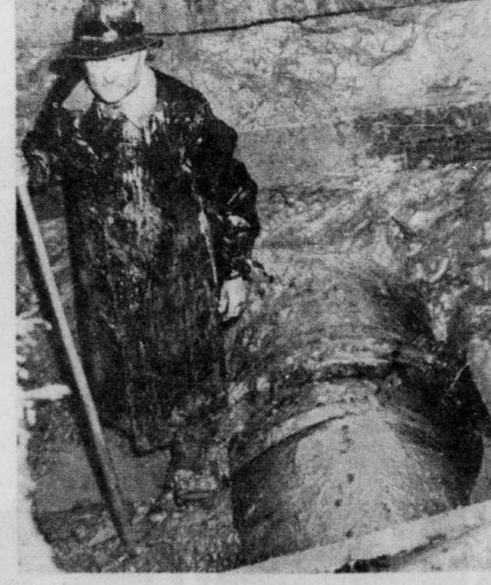
BRIS DU "30 POUÇES": Un terrain vacant bordant la rue Gauvin, à Québec-Ouest, a été inondé hier en même temps que la cave de quelques maisons environnantes à la suite de la rupture du "30 pouces". Les préposés du service municipal de l'aqueduc s'employaient déjà depuis quelques heures à la réparation d'un raccord défectueux, lorsque la pression fit tout à coup céder le terrain. Aucun ouvrier n'a été blessé dans l'accident, mais celui qui travaillait près du conduit a été fait de bondir hors de la fosse complètement détrempe. Sur le cliché du haut, on aperçoit l'étendue d'eau qui a recouvert le sol et un mécanicien qui met une pompe en action. Sur celui du bas, on voit, au fond d'une excavation, le tuyau en partie découvert. (Photos du "Soleil")
