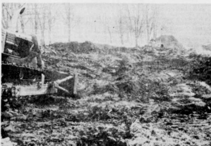
POUR LE MOIS D'OCTOBRE. — Les béliers mécaniques ont commencé à creuser le sol où sera érigé le Palais des sports de Sherbrooke. (Photo La Tribune, par Studio Breton)
