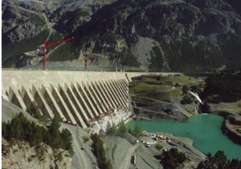
Les installations hydro-électriques de Cancano "I" jouent un rôle primordial dans l'approvisionnement énergétique de la région
