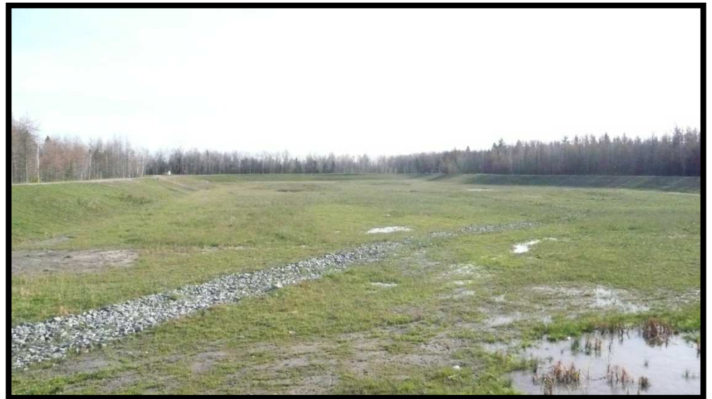
Réservoir de rétention des eaux ( \pm 100\,000\text{ m}^3 )
