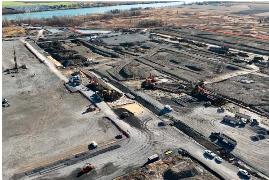
Une ligne électrique et une conduite souterraine d'égout sanitaire doivent être construites. (Photo : archives)
