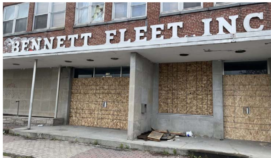
La Ville souhaite que l'usine Bennett Fleet soit démolie cet été. (Photo : archives)
