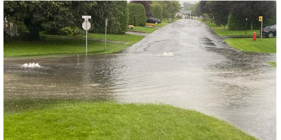
L'eau s'accumule à l'angle de la 3 e Rue et de la 16 e Avenue. (Photos : courtoisie)
