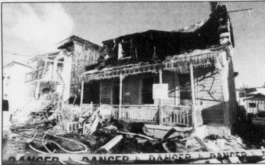
Un feu qui a pris naissance dans une voiture a causé des dommages considérables à deux bâtiments de la rue Saint-Paul à Trois-Rivières.
