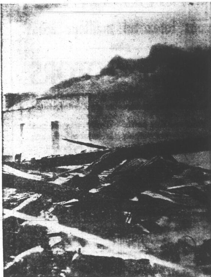
AU PLUS FORT DE L'INCENDIE — Les pompiers sont à l'oeuvre alors que le sinistre fait rage dans un immeuble de deux étages, au numéro 2461, boulevard Lévesque, dans la municipalité de St-Vincent-de-Paul. En dépit de l'excellent travail des pompiers, il a été impossible de limiter le feu à l'arrière de la maison où il a pris naissance. (Photo "Montréal-Matin" par David Bier)
