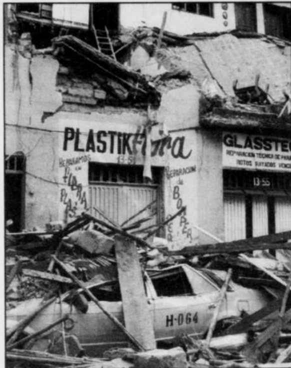
Plus de 3000 personnes sont sans abri à Pereira ainsi que dans les villes voisines et plus de 600 immeubles ont été détruits ou gravement endommagés.
