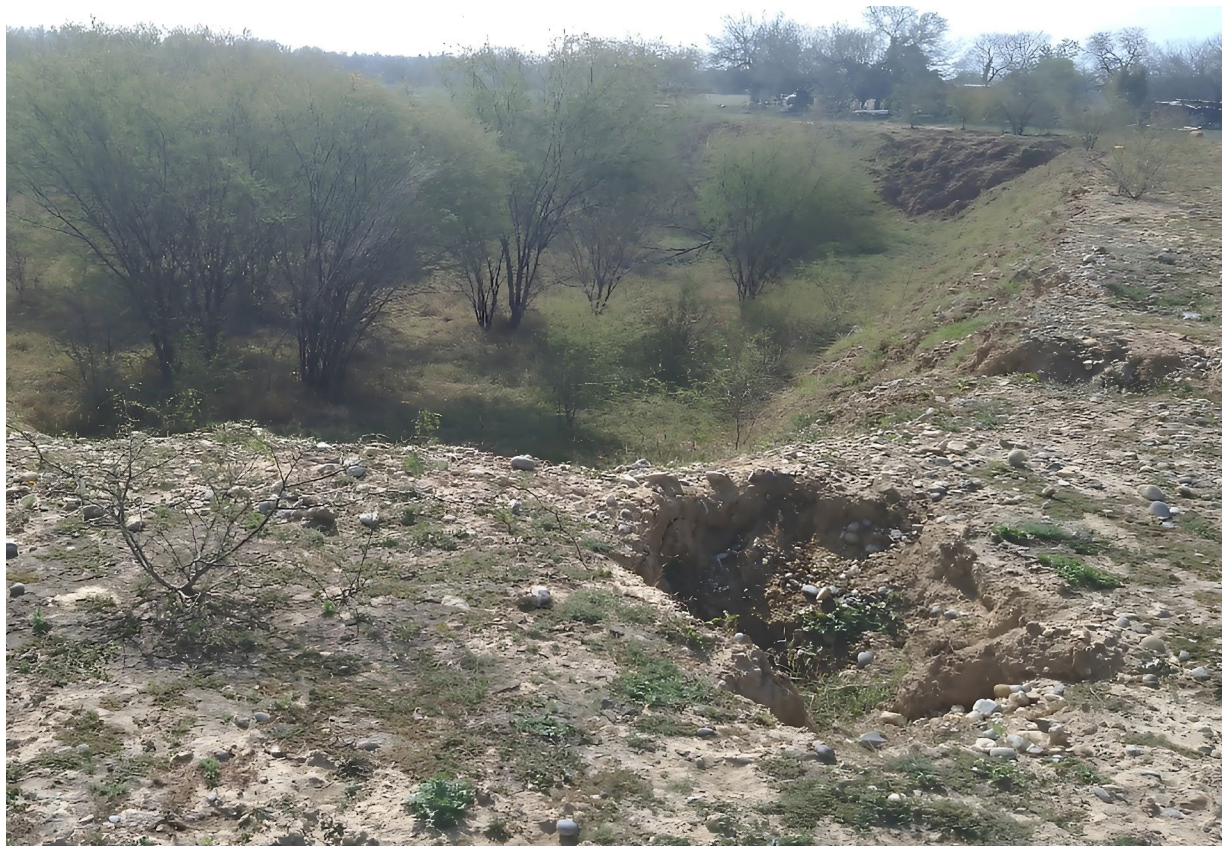
Photo 4. Réservoir attenant au puits Nerita-1
