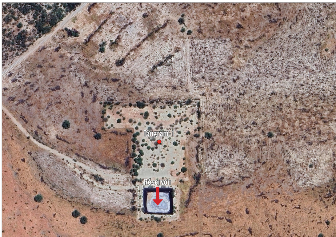
Figure 17. Emplacement du réservoir attenant au puits Tangram-1
