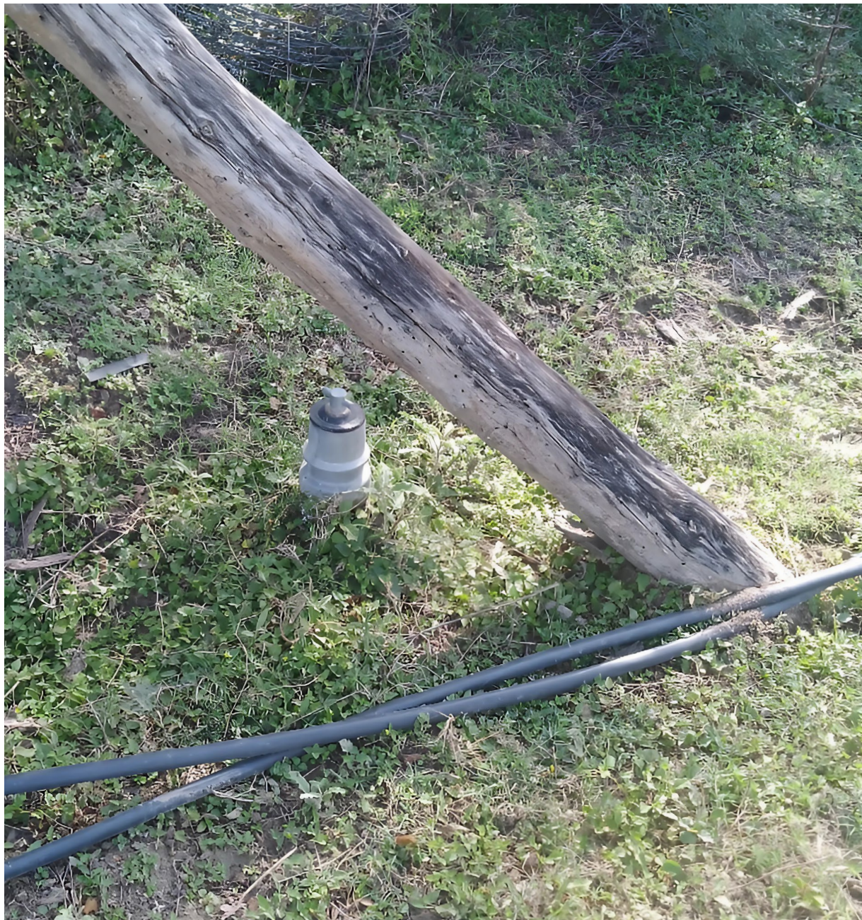
Vanne d'arrêt montée sur un tuyau en PVC pour l'irrigation agricole, localité de Las Puertes, municipalité de Los Ramones, Nuevo León. Photo prise le 22 février 2024 lors de la visite de terrain du Secrétariat. Annexe photographique disponible à l'adresse : < cec.org/files/sem/20240613/aau012.docx >.
