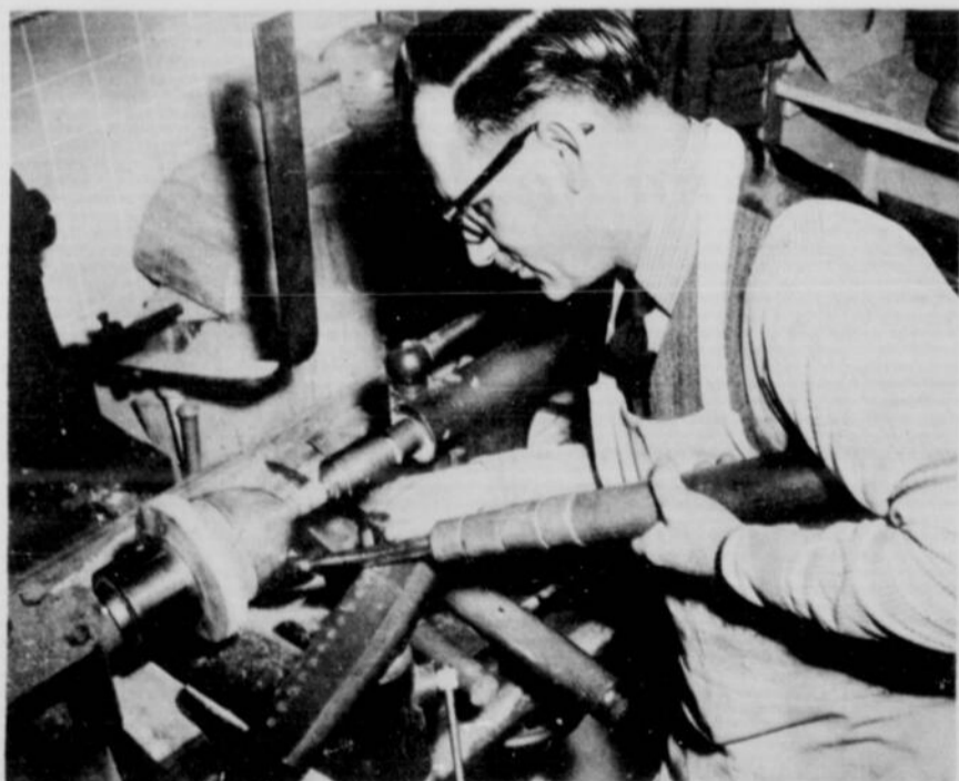
M. Marcel Poirier travaillant au tour pour former la coupe d'un calice avec un morceau d'argent pur.
