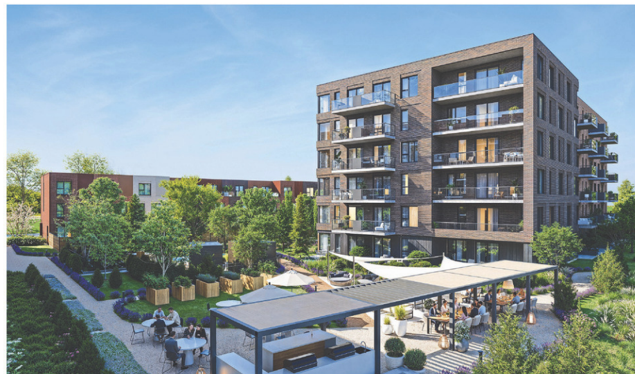
Aperçu d'un futur bâtiment du Quartier Louka et de quelques installations extérieures.
