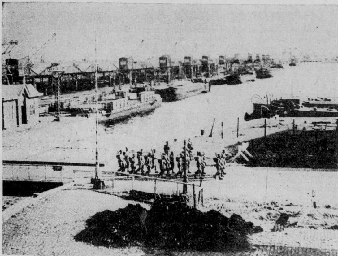
LE PORT D'ANVERS : Un détachement de troupes britanniques s'en va monter la garde sur les docks du grand port belge d'Anvers, qui est tombé intact aux mains des Alliés et dont l'entrée se trouve maintenant ouverte.
