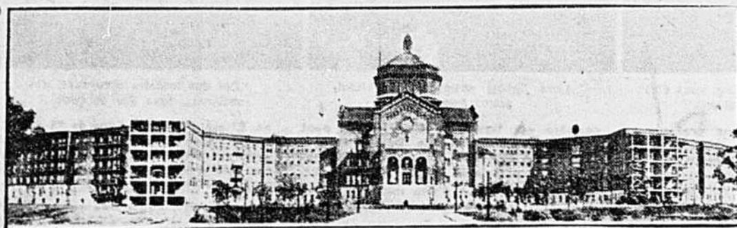
Une vue générale de l'hôpital du Sacré-Coeur, à Cartierville.
