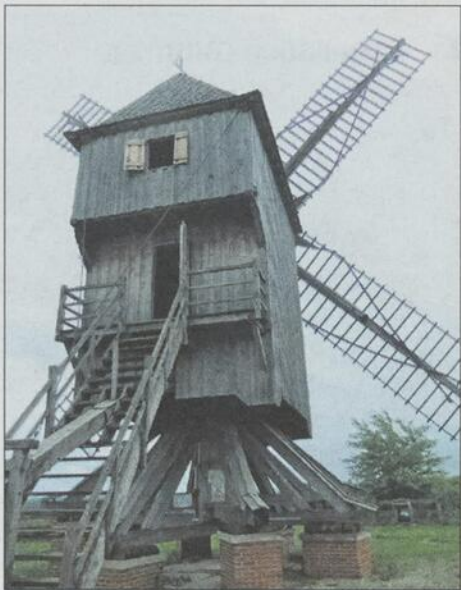
Le moulin à vent de Dosches, tout en bois, monté sur un pivot qui tourne en fonction de la direction du vent.
