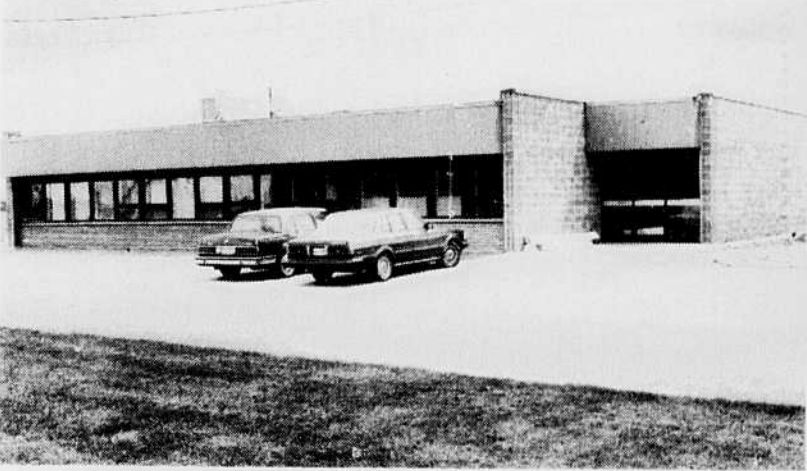
La construction du centre administratif de la MRC d'Arthabaska, a été complétée avant la date prévue du 9 juillet.
