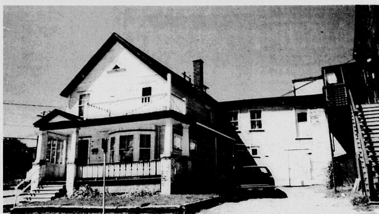
Cette maison de style vernaculaire américain, rue Gillespie, derrière le commerce Kandalaft, a croulé sous le pic des démolisseurs.
