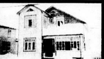
819 de la Grève 2 logements près de l'école
