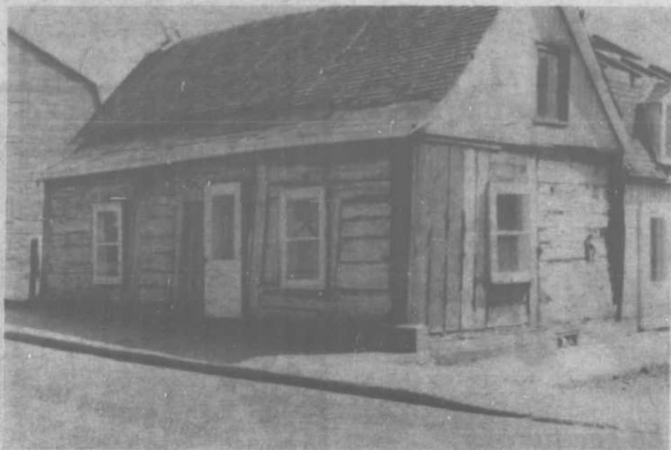
En démolissant la propriété de la famille Daunais, on a découvert sous le papier brique qui la recouvrait un genre de construction en madriers de toutes formes, comme posés à la hâte avec des chevilles de bois et des clous carrés.
