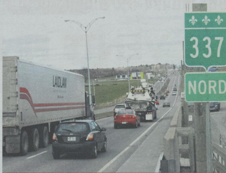
L'élargissement de la route 337 dans le secteur La Plaine, dont les travaux devaient se terminer en 2017, sera finalement complété ultérieurement, a appris le journal La Revue lors du dévoilement de la programmation des investissements routiers 2015-2017 du ministère des Transports, le 24 avril.
