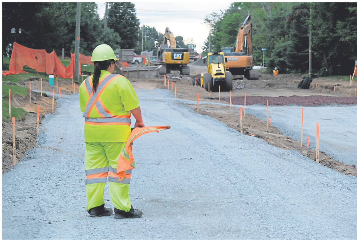
Une signaleuse est en place sur le chantier de la rue Saint-Hubert pour sécuriser les déplacements des élèves marcheurs de l'école Joseph-Poitevin. — PHOTO ALAIN DION
