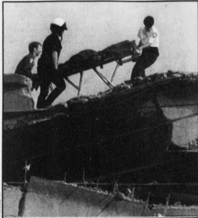
Le corps d'un automobiliste tué dans l'effondrement d'une section de l'autoroute 880, à Oakland, est retiré des décombres par les secouristes.
