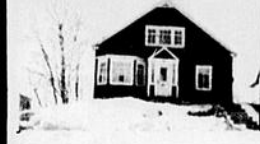
79 LAURIER—Cottage 2 étages 29X31, chauffage eau chaude comprenant 3 logements dont 2 entièrement meublés.
