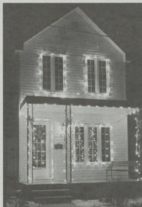
L'installation d'une minuterie à votre système d'éclairage de Noël permet des économies d'énergie appréciables.
