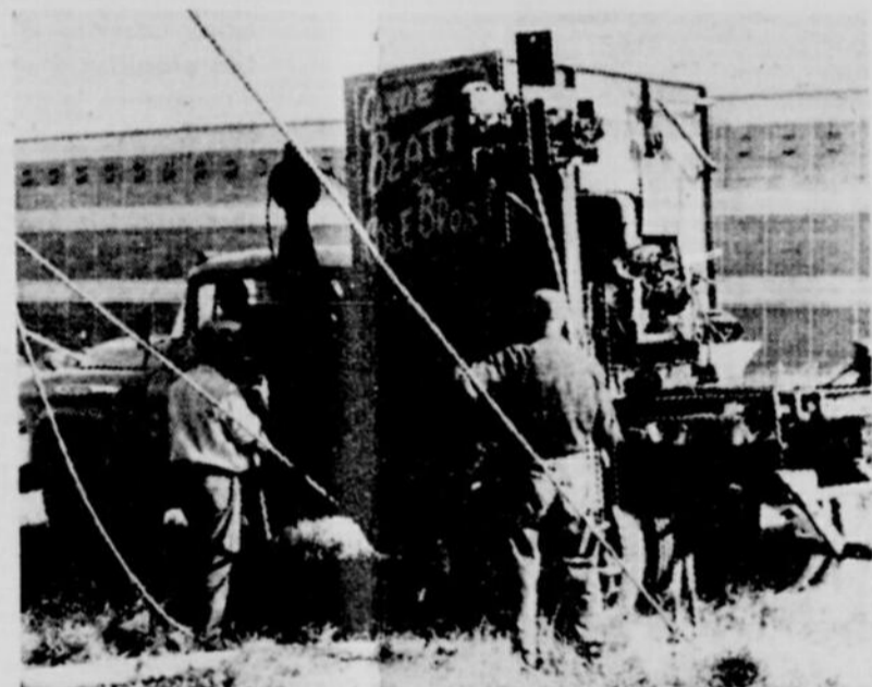
Pour les plus gros pieux, voici une admirable mécanique qui épargne bien de "l'huile de bras" aux ouvriers monteurs.
