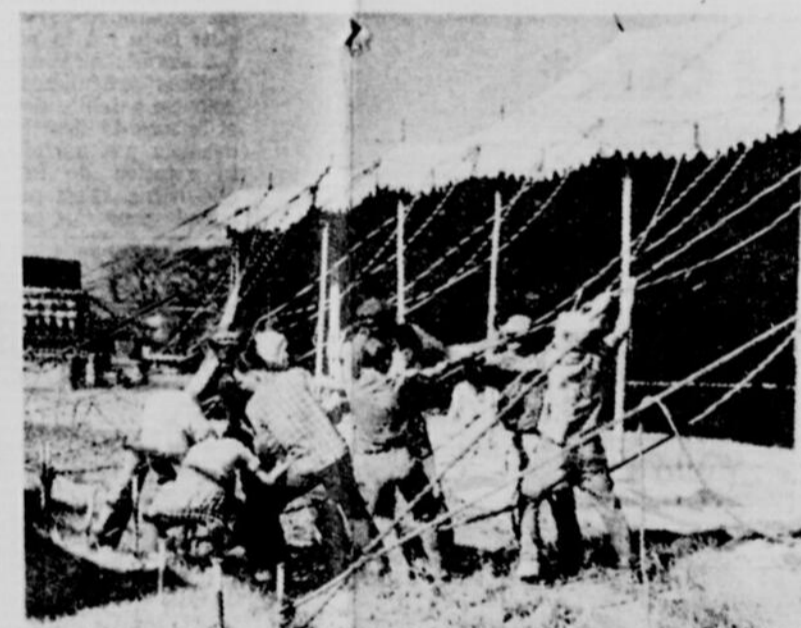
L'intérieur est terminé: il s'agit maintenant de fixer solidement la tente en la renforçant par des "haubans".
