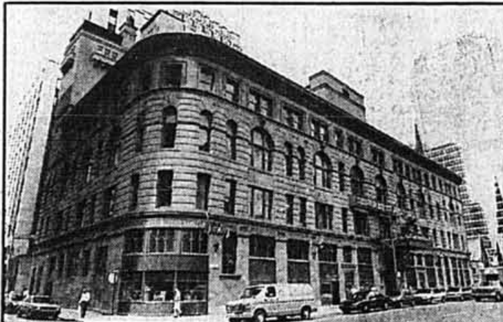
Les faces est et sud de l'édifice
