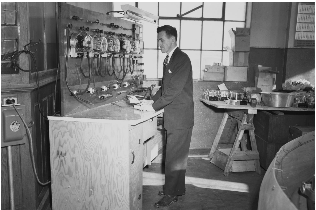
Dumont à l'usine électrique de Mont-Laurier, en 1956. Source : P27 Fonds Alcide Boudreault.
