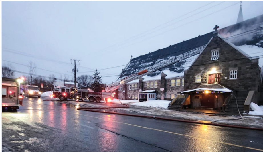
C'est à la toiture du pignon d'une porte et à la cage d'un escalier de côté, que le feu a fait rage à l'ex-église de Sainte-Marcelle.
