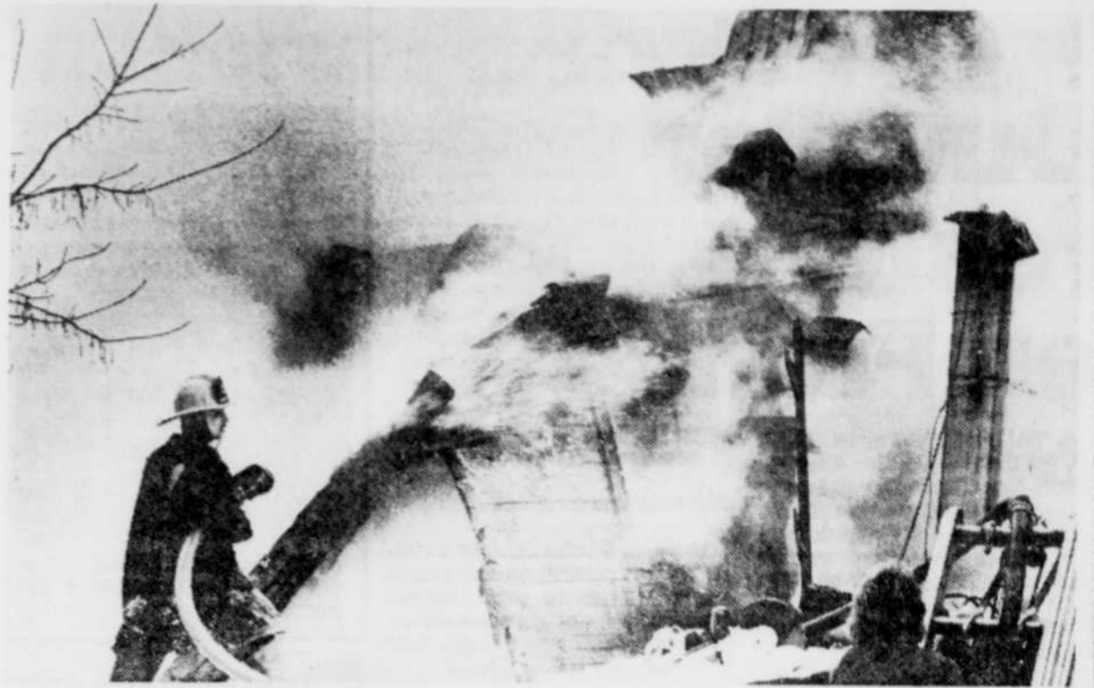
Une heure de travail acharné mené par une vingtaine de pompiers de Loretteville a vaincu l'incendie, mais il était quand même trop tard, il ne restait presque plus rien de l'usine.
