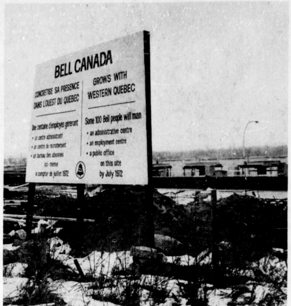
Les travaux sont présentement en cours à l'angle du boulevard St-Joseph et de la rue St-Raymond, à Hull, le site du futur centre administratif de Bell Canada pour l'ouest du Québec. L'édifice logera une centaine d'employés de la compagnie, ainsi que le centre de recrutement et le bureau des abonnés.
