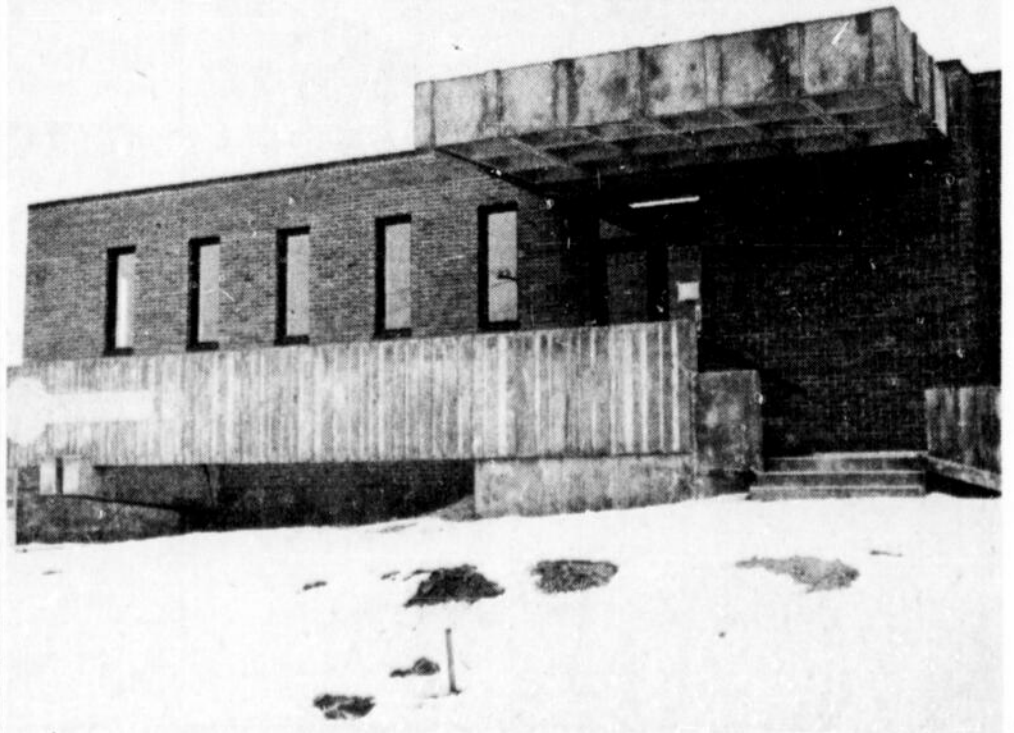
La construction du nouveau bureau de l'assistance-annuaire, boulevard Montclair, à Hull, est presque terminée. Les installateurs de Bell Canada doivent maintenant y installer l'équipement en vue d'accueillir une soixantaine de téléphonistes, à compter de l'été prochain.
