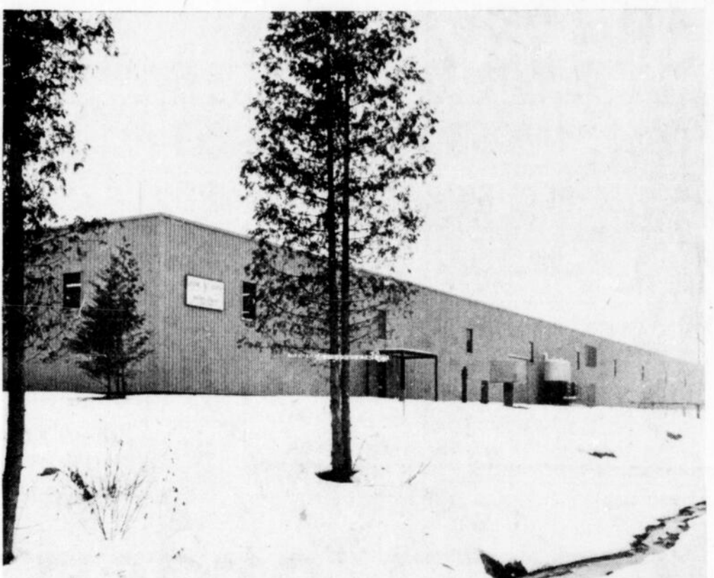
La Northern Electric, filiale principale de Bell Canada, a maintenant une usine à Lucerne, chargée de la fabrication de circuits et autres pièces d'équipement téléphonique. Ce vaste édifice n'est que la première phase de l'établissement de cette compagnie dans l'ouest du Québec.
