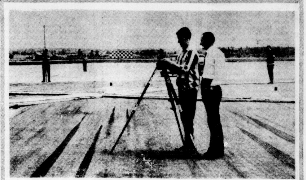
UNE CROIX BLANCHE indique aux pilotes la fermeture de la piste 06-24. Des ingénieurs font les travaux préparatoires à la pose d'une couche de 12 pouces de béton.
