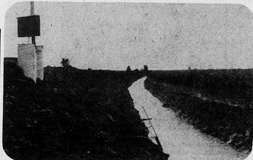
Cette photo nous montre le fossé dans lequel se déversent les eaux de ses terres ainsi que la digue qui a été érigée pour contrôler le niveau de l'eau. Sous les deux tuyaux érigés sur la digue se trouvent les pompes servant à stabiliser le niveau d'eau. [Photo Rosaire Lemay].
