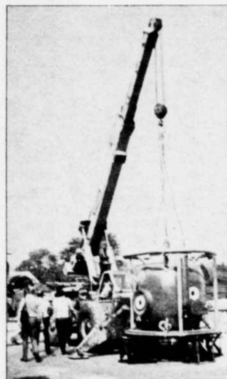
Cage anticourant permettant au scaphandrier un travail méticuleux et sécuritaire.
