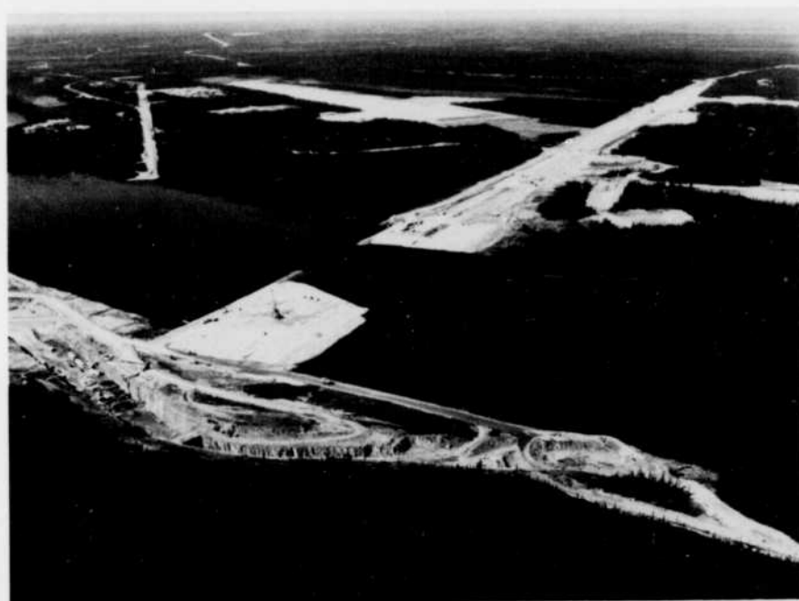
Rivière Eastmain – Barrage OA-11 et Evacuateur de crues en construction
