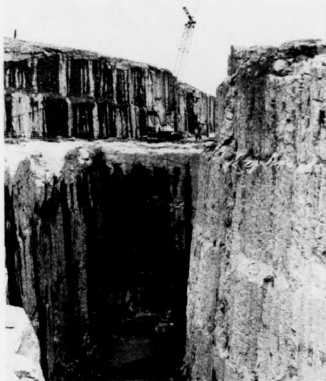
Caniapiscou — Canal d'amenée et portail d'entrée de la galerie de dérivation provisoire
