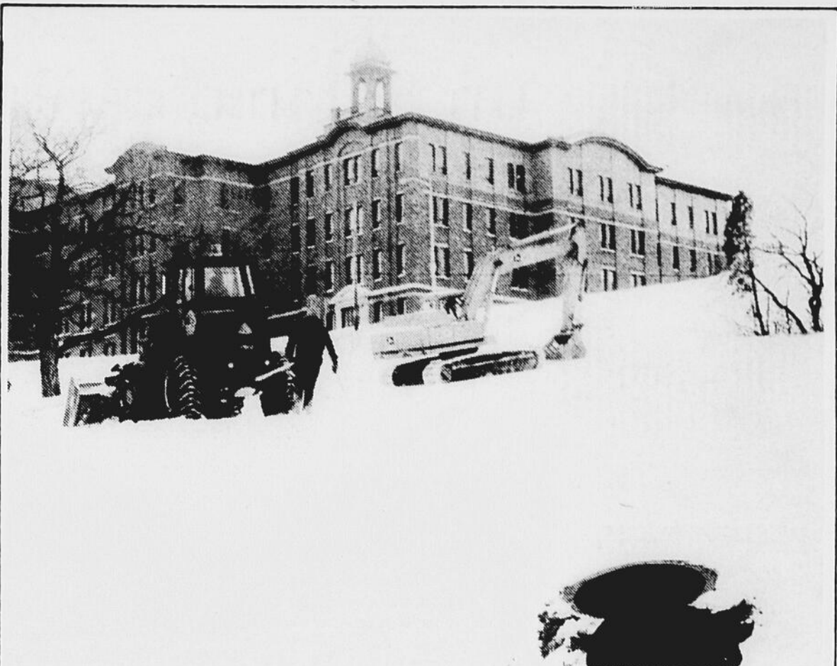
TRAVAUX — Eh bien non! Le Cégep de Chicoutimi ne subit pas de cure de rajeunissement. C'est simplement que la ville de Chicoutimi procède actuellement à certains travaux à l'entrée du cégep... voilà qui explique la présence des mastodontes! (Photo Jeannot Levesque)
