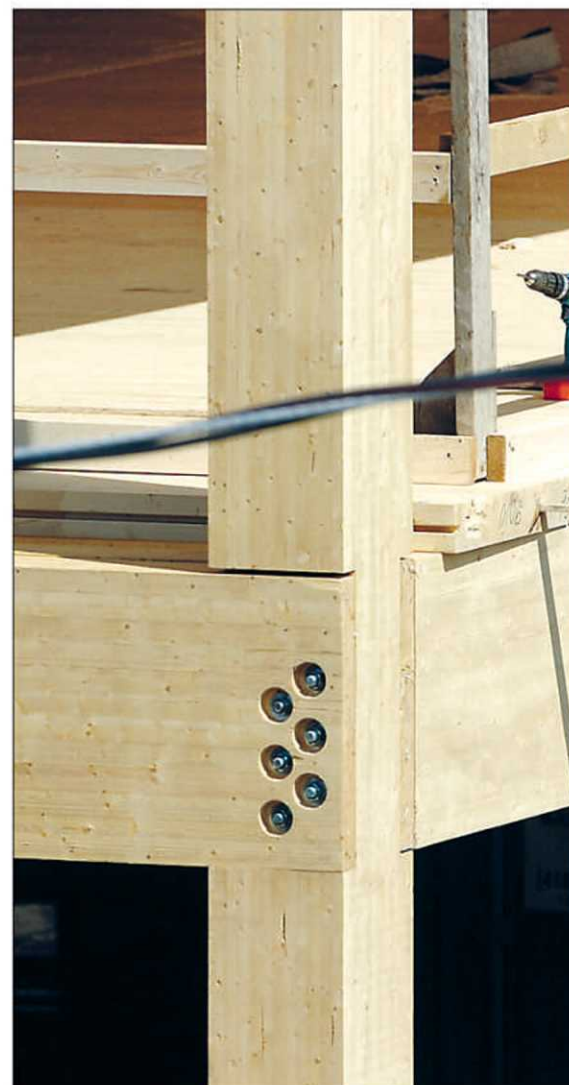
Ce type de structure en «bois construit» intrigue plusieurs automobilistes et passants. Sur la photo de droite, un détail de l'assemblage d'un palier. — PHOTOS LE SOLEIL, JEAN-MARIE VILLENEUVE
