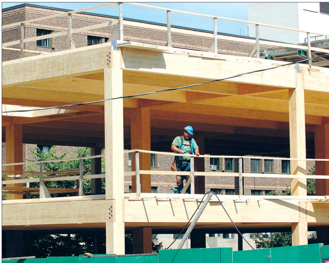
Ce type de structure en «bois construit» intrigue plusieurs automobilistes et passants. Sur la photo de droite, un détail de l'assemblage d'un palier. — PHOTOS LE SOLEIL, JEAN-MARIE VILLENEUVE
