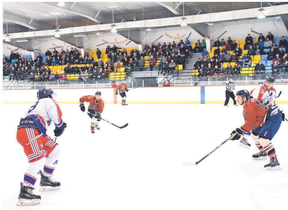
Le Centre récréatif Gérard-Couillard, un bâtiment vieux de 50 ans, devra faire l'objet de travaux supplémentaires. Ceux-ci devraient faire grimper la facture totale à un peu plus de cinq millions de dollars. (Photo Le Progrès de Coaticook - Vincent Cliche)
