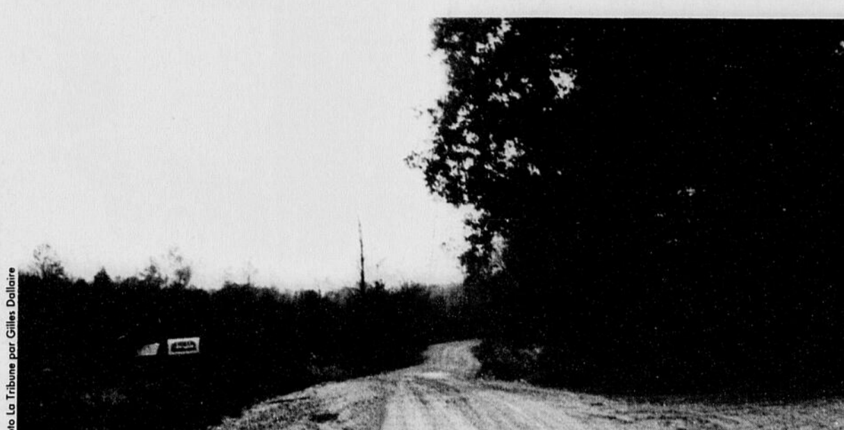
Photo La Tribune par Gilles Dallaire Avant que des travaux d'entretien ne soient exécutés par Excavation Réal Barrette, le côté nord du chemin Shuttleworth était bordé d'arbres, comme le côté sud, à la hauteur de la propriété de Lucie Fournier et d'André Lapointe.
