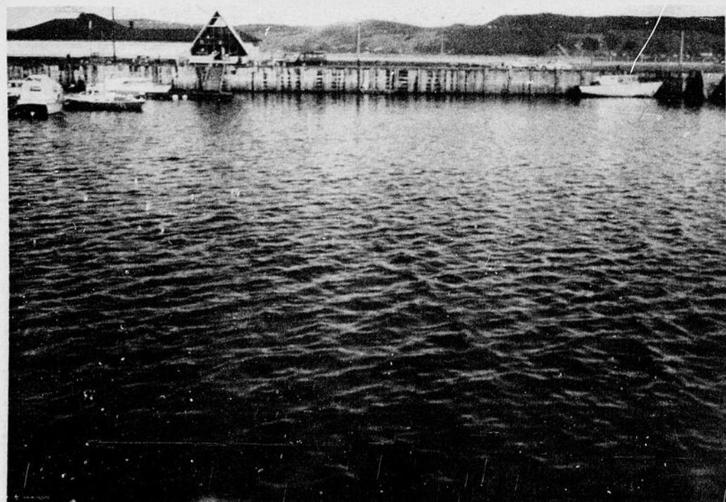
D'ICI DEUX A TROIS ANS , le bassin du quai de Bagotville, ci-contre, sera entouré de quais flottants, espèrent les membres de la Marina de la Baie. Il devra en être ainsi, estime-t-on, afin de répondre aux exigences des propriétaires de bateaux et de chaloupes. Le Commodore Yvonick Desbiens dévoilait les dizaines de demandes en provenance de Québec, des environs, et du Lac St-Jean. Les requérants désirent un endroit bien organisé, à proximité des commodités et surtout, beaucoup d'espace d'eau pour se promener dans la rade comme aller à Chicoutimi ou sur le fleuve St-Laurent.
