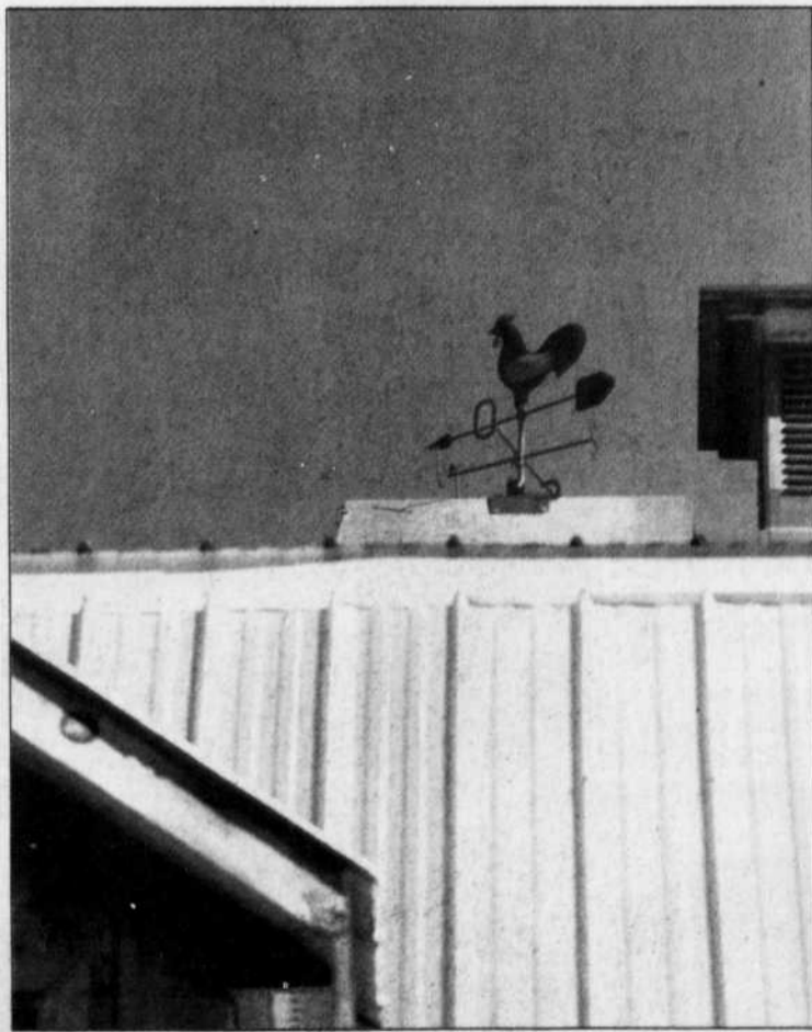
Ici, le clocheton d'aération, la lucarne à pignon, le toit à la canadienne (qui utilise la technique de tôle à baguette) et la girouette, captés sous l'azur du ciel, de charmants détails que l'on peut embrasser d'un seul regard.
