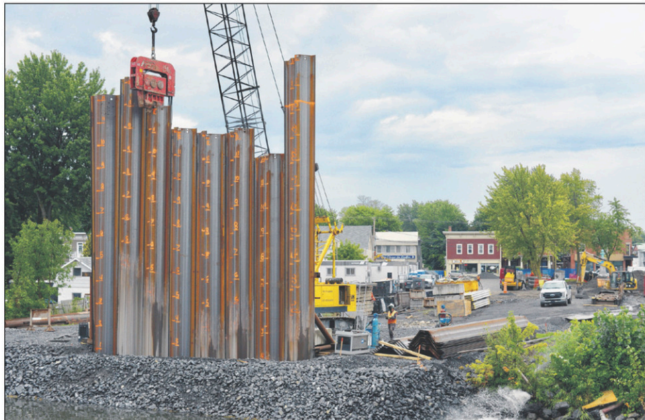
Un mur de palplanches empêchera l'eau de pénétrer dans la tranchée d'excavation pour installer l'émissaire pluvial. C'est le même ouvrage qui a été fait en bordure du canal, juste au sud du pont.
