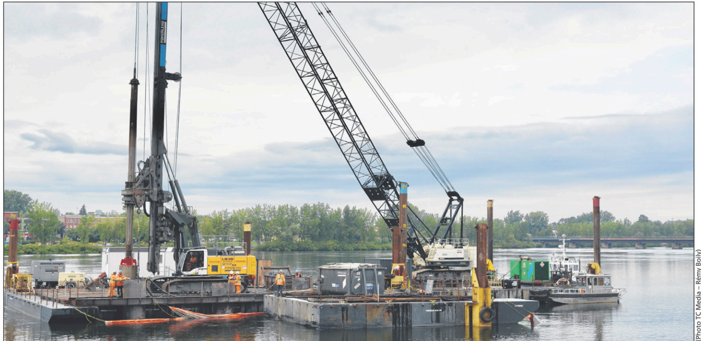
La machinerie installée sur des chalands sert à poser les pieux caissons.
