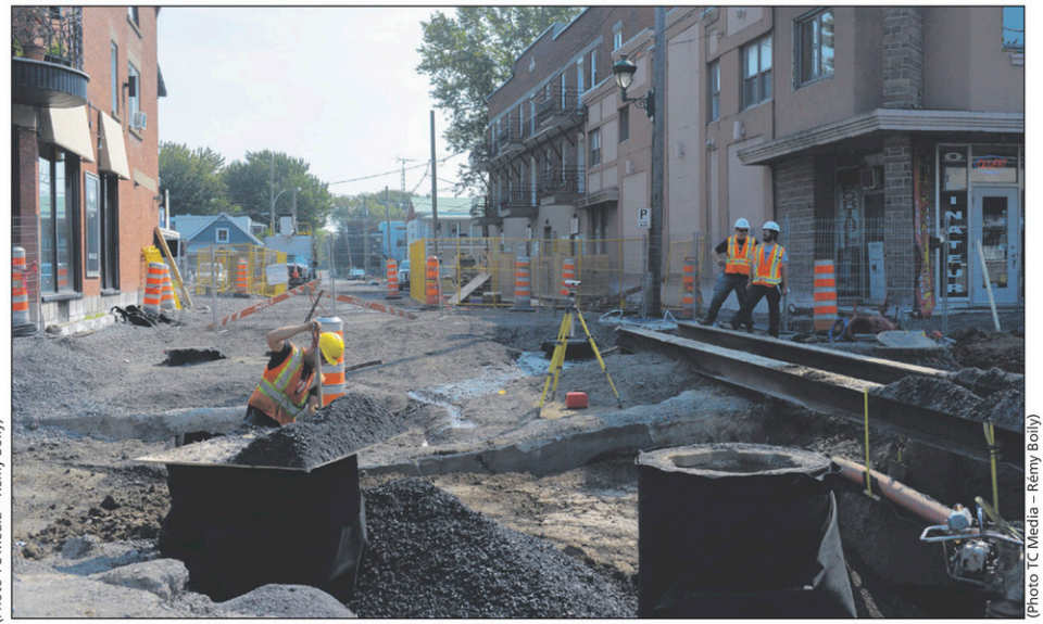
L'excavation de la 1 re Rue se fait minutieusement pour trouver les différents ouvrages souterrains.
