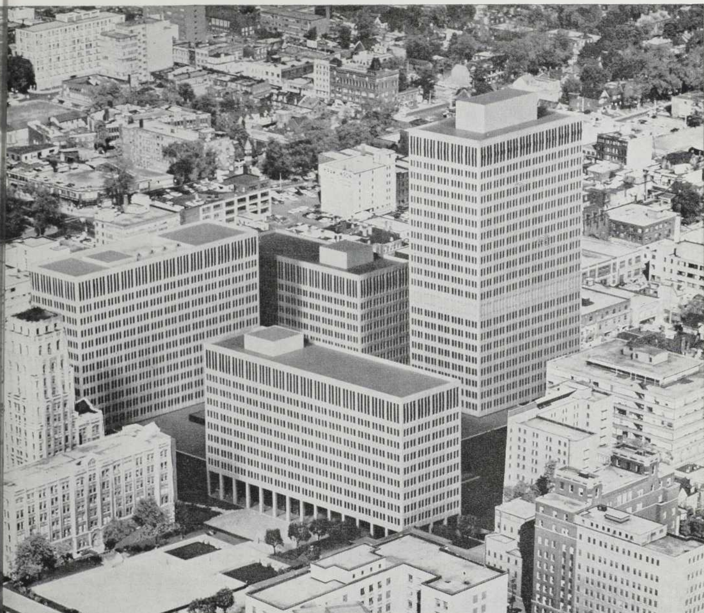
Le Queen's Park Office Extension Program de la Province d'Ontario, sera climatisé par un système Trane. Propriétaire : Province d'Ontario, Hon. John Robarts, Premier Ministre, Hon. Ray Connell, Ministre des Travaux publics, Architectes associés: Gordon S. Adamson & Associates; Allward & Gouinlock; Mathers & Haldenby; Shore & Moffat and Partners. Spécialiste en mécanique : H. H. Angus & Associates Ltd. Entrepreneur général : Perini (Western) Limited, Entrepreneur en mécanique : Universal Plumbing Heating Co. (1961) Ltd., Toronto.
