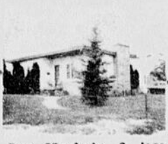
Rue Murdoch, 2 logements.
