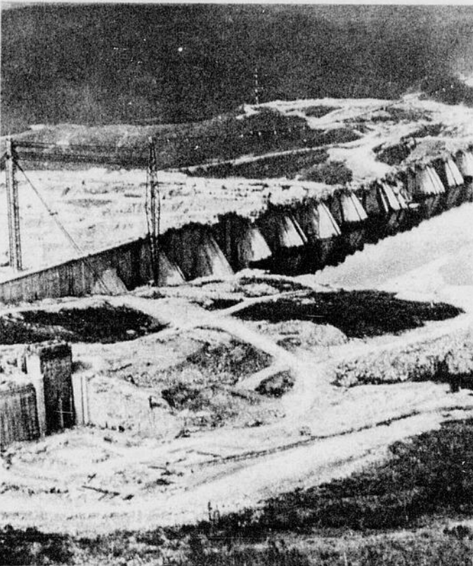
MANIC 5, le côté amont du barrage et la prise d'eau.
