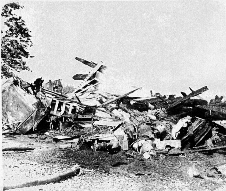
PERTE TOTALE. — La maison de M. Joseph Mercier, de Cap St-Ignace, est une perte totale, ayant été détruite par le feu, mardi matin, quand un lourd camion-remorque s'est enfoncé dans la maison et a explosé sous le choc. Le conducteur du camion fut transporté à l'hôpital, et les 9 membres de la famille Mercier s'en sont tirés indemnes, mais se retrouvent sur le pavé.
