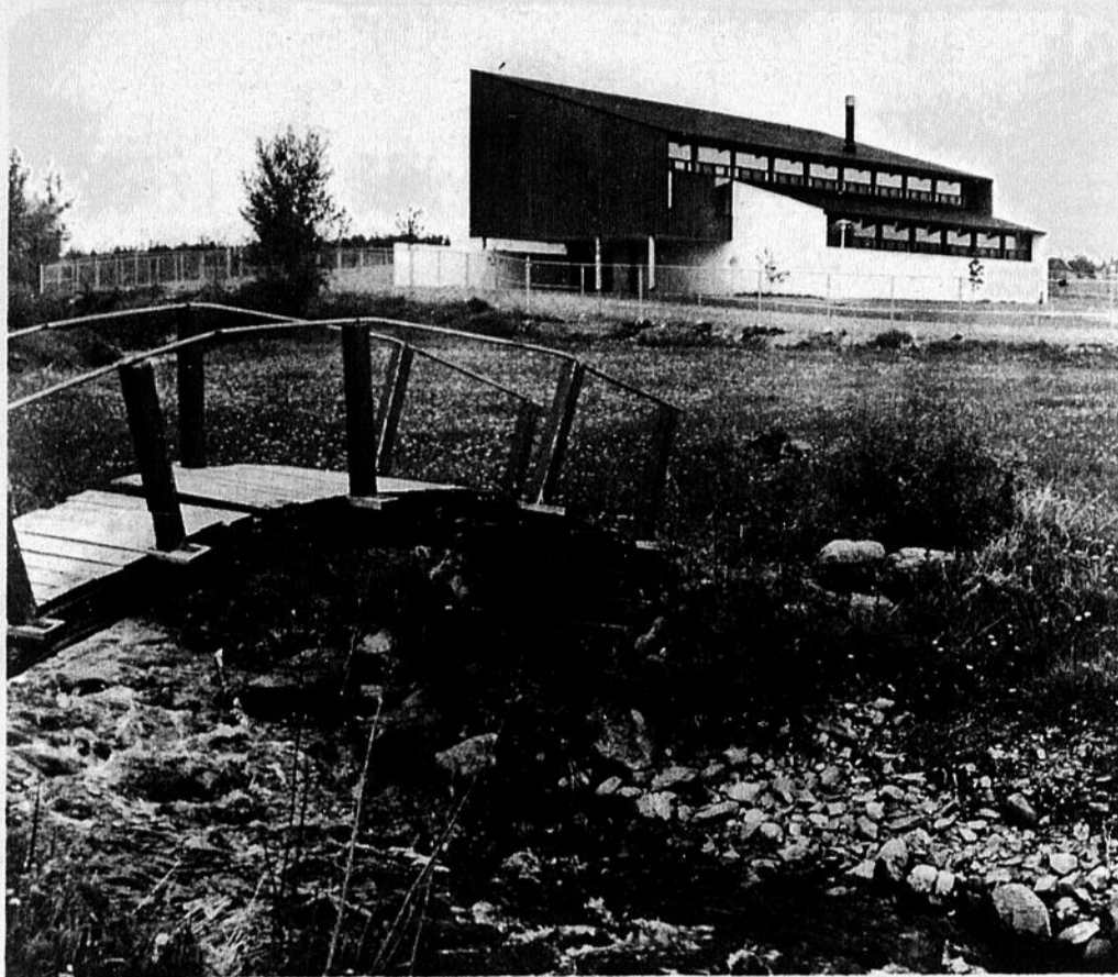
Surtout quand l'année académique tire à sa fin, il fait bon de se reposer près d'un cours d'eau pour regarder l'école. De plus, quand cette école est une construction récente comme c'est le cas ici, à Ste-Félicité. En fin de semaine on y célèbre le vingt-cinquième anniversaire de fondation de la paroisse.
