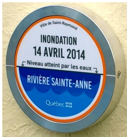
Figure 7. Repère de crue installé à Saint-Raymond
