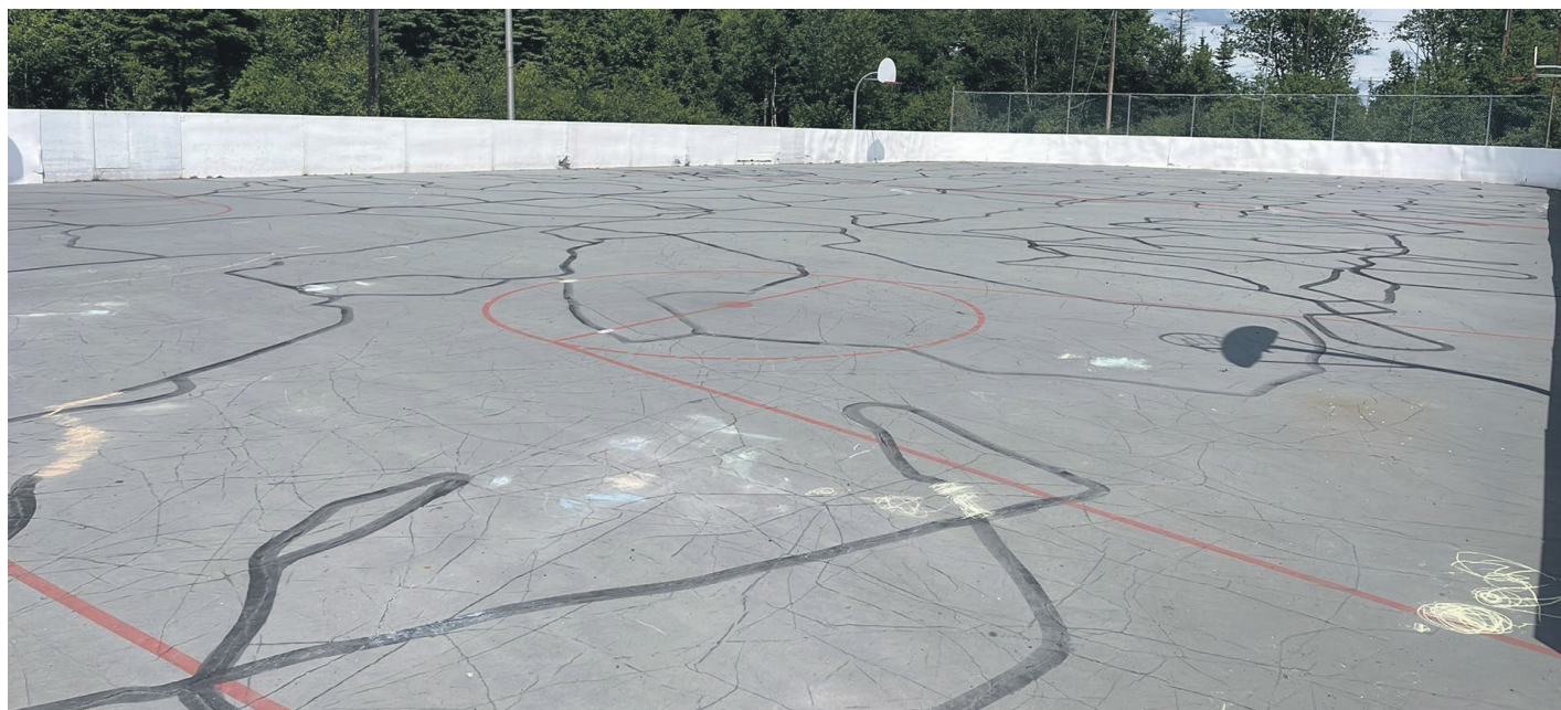
La patinoire du Centre Cartier de Port-Cartier se fera une beauté à l'automne, notamment pour y ajouter une surface de dek hockey pour l'été 2025. Photo courtoisie
