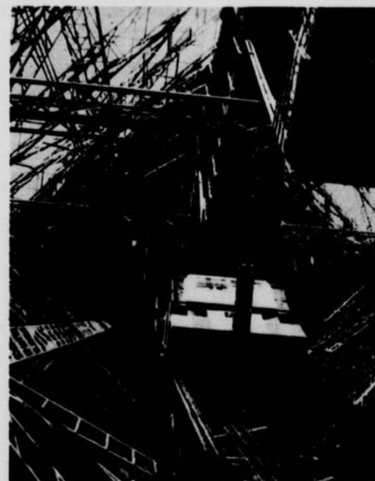
Sept millions de tonnes d'acier réunies au moyen de boulons. L'un de ses ascenseurs monte à la première plate-forme.
