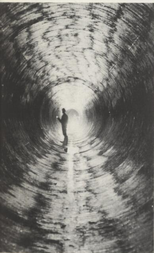
Par un tunnel de 7½ milles de longueur et de 31 pieds de diamètre, l'eau captée à la chute, est amenée à la centrale de Bersimis. Ici un ingénieur procède à l'inspection d'une des conduites forcées.
